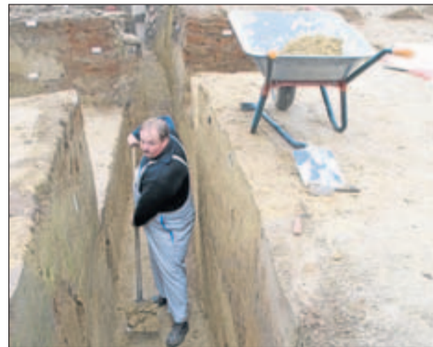
Michael Schenk gräbt in einer Tiefe von 1,90 Meter – eine anstrengende Arbeit, denn die Erde muss er mit der Schaufel über seinen Kopf in die Schubkarre werfen.
